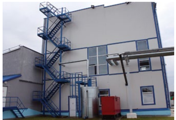
Модернизированная котельная на местных видах топлива (МВТ) в Боровлянах – образец современного эффективного теплоузла.
